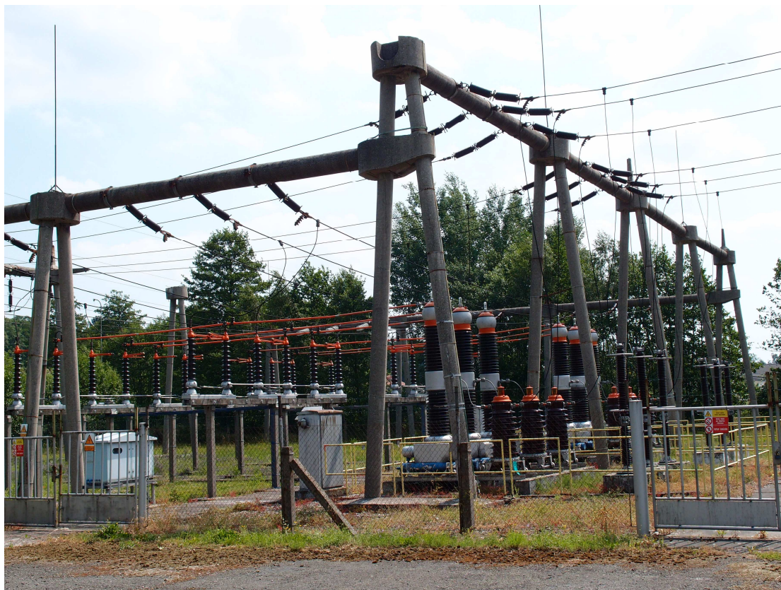
Obr. 7 Pole rozvodny 110 kV TNS Týniště n/O. s vypínači PTP za zábradlím pro základní ochranu zábranou a ovládací skříň s kabelový kanálem zakrytým panely
