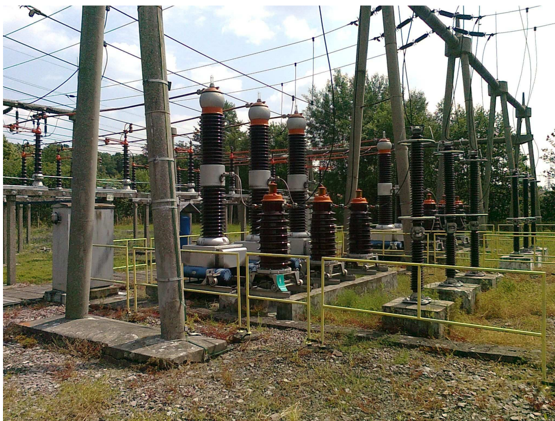
Obr. 6 Pole rozvodny 110 kV TNS Týniště n/O. s vypínači, PTP a bleskojistkami 110 kV za zábradlím pro základní ochranu (ochranu před neb. dotykem živých částí) zábranou
