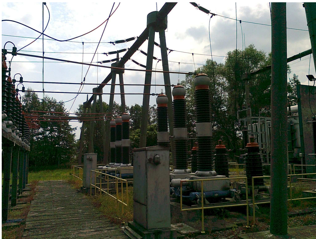
Obr. 7 Pole rozvodny 110 kV TNS Týniště n/O. s vypínači PTP za zábradlím pro základní ochranu zábranou a ovládací skříň s kabelový kanálem zakrytým panely
